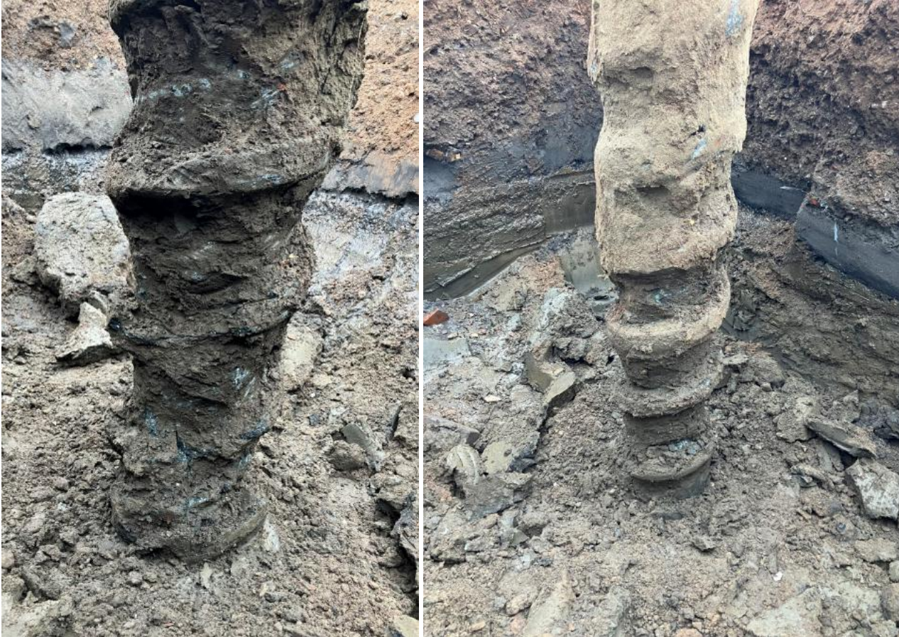
FIGUUR 23 VRIJGRAVEN PALEN TE WERKENDAM. ZICHTBARE KLEILAAG OP LAAG SCHEIDING.
